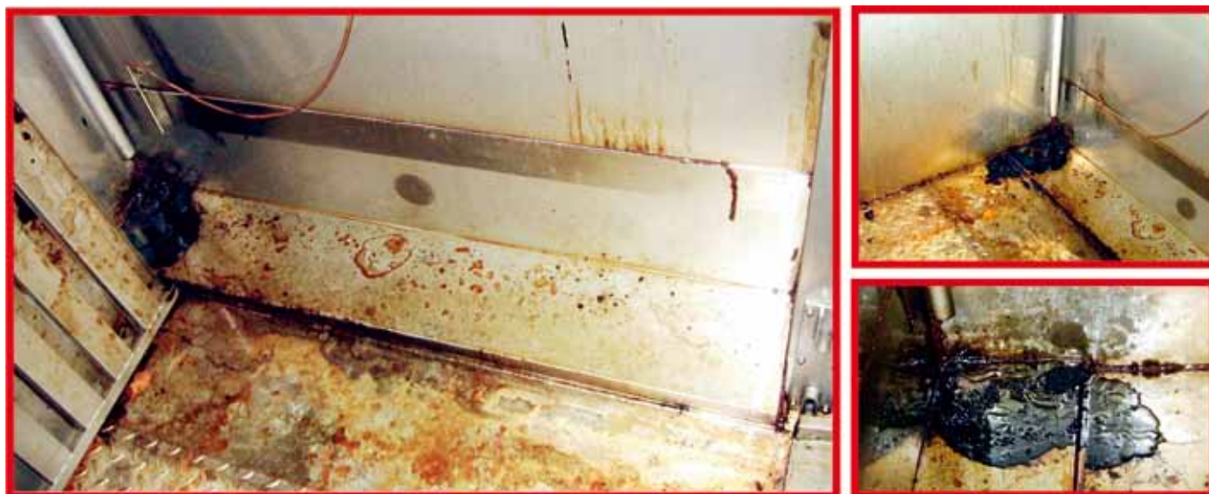
Fot. 4. Niedomyte zanieczyszczenia (smółka) wewnątrz komory.
