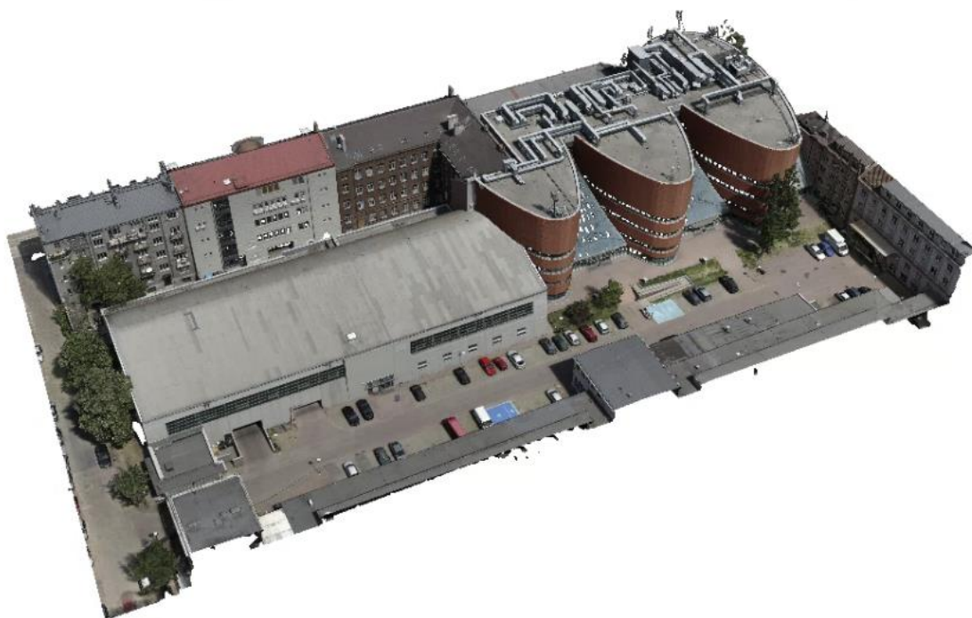
Fotografia 1. Kompleks zabudowy Menedżerskiej Akademii Nauk Stosowanych w Warszawie Źródło: dokumentacja wewnętrzna MANS
